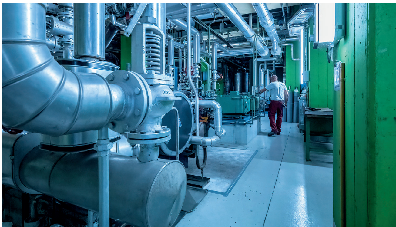
Mit dem Ersatzneubau kann die KEZO die Fernwärmeabgabe erheblich steigern.
